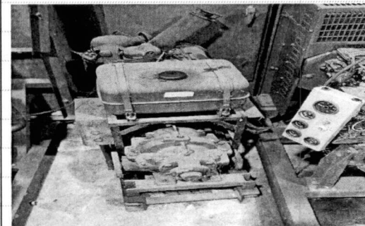
40. เครื่องสูบน้ำดับเพลิง ดีเซล ตึกพิลึกส์ - คณิตศาสตร์
