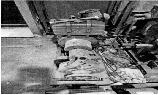
43.เครื่องสูบน้ำดับเพลิง ดีเซล ตึกพลังงาน
